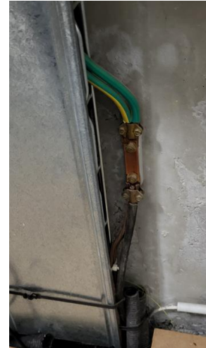
Photos 8 : Barre d'équipotentialité poste de livraison & terre local électrique bureaux
