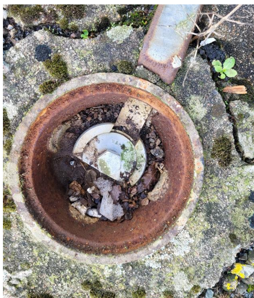
Photo 10 : Regard de visite et raccord patte d'oie.
