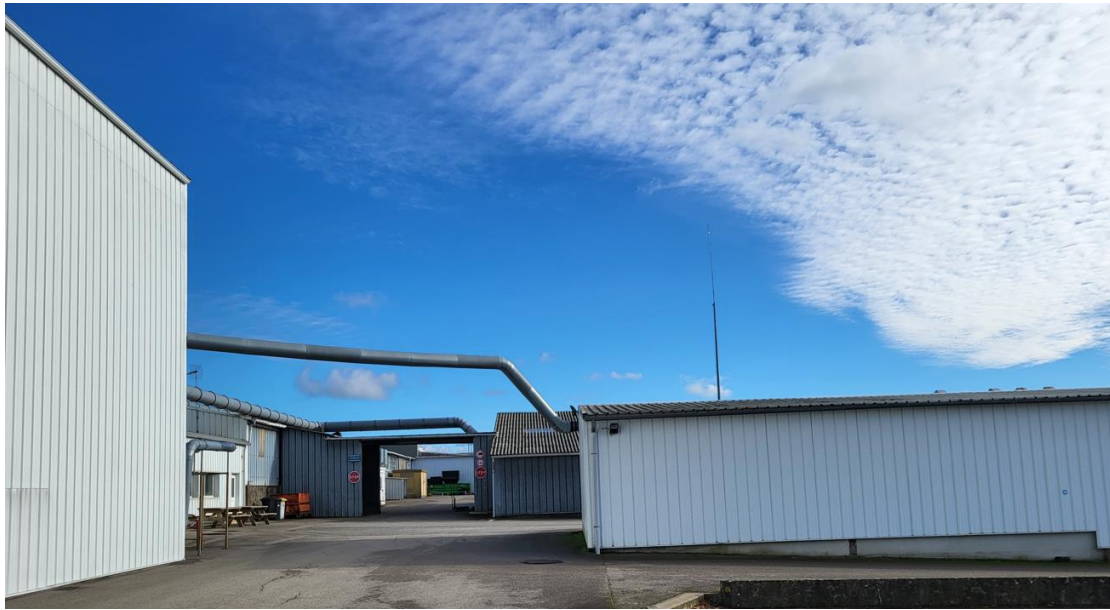
Photo 5 : Angle Aspiration & bâtiment vernis Panneaux et paratonnerre existant
